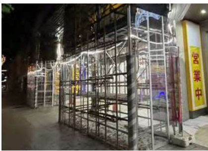
店舗外装工事
