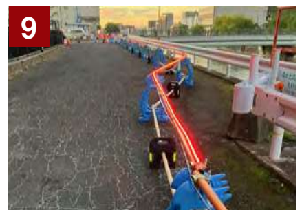
バリケードフェンス取り付け
