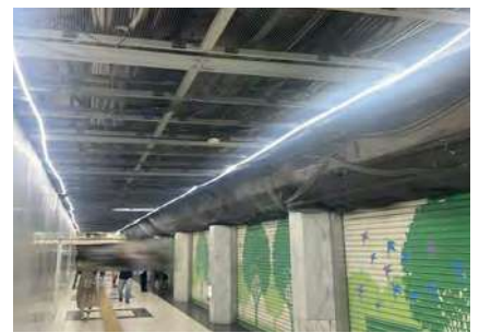
駅構内改修工事
