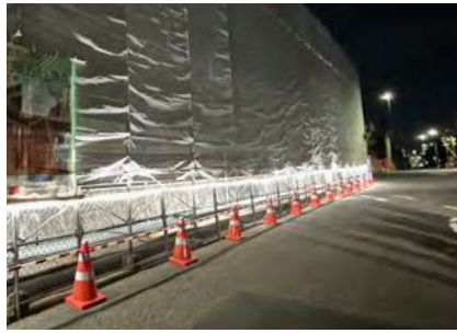
国道架け替え工事
