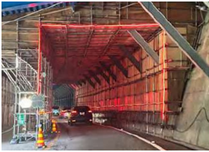
国道洞門補修工事
