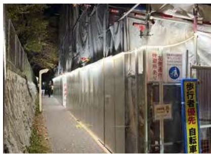
歩道橋補修工事
