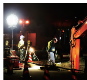
土木・道路工事
